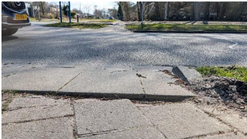
Stoep (kruising Slotlaan/Elswood) Stoeptegels en rand omhoogstaand
