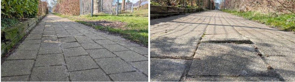
Stoep Kasmphuysen (t.h.v. nr. 5) opstaande tegel
