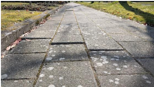
Stoep Kasmphuysen (t.h.v. nr. 5) opstaande tegel
